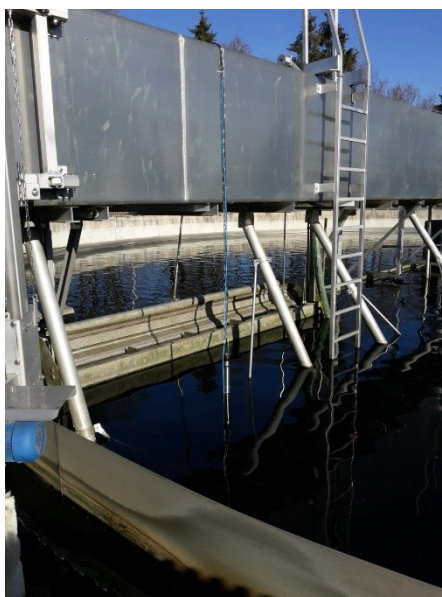
Abb. 3: Installation des Sensors NiCaVis® 705 IQ im Nachklärbecken der Kläranlage Peißenberg
