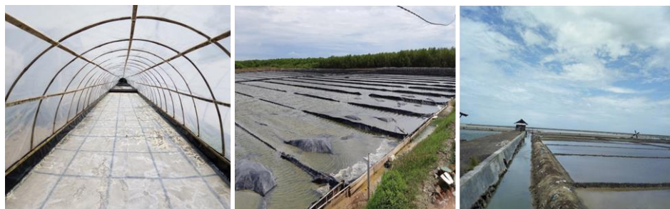
Abb. 2: Typische Aufbauten von Tunnel (links), Geomembran (mitte) und traditioneller Becken (rechts) zur Meersalzgewinnung (Dwiyitno et al. 2021).
