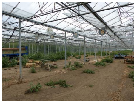
Abb. 6: Die Gewächshäuser konnte Christoph Decker lange nicht mehr nutzen, der Verbraucherschutz hatte Priorität.
