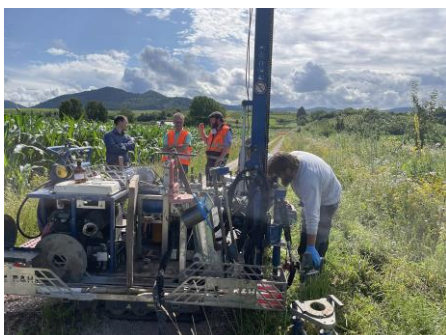
Abb. 2: Mit Bohrungen geht man der PFAS-Belastung im Grundwasser nach.
