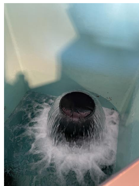
Abb. 4: Die Trinkwasserversorger der Region mussten Maßnahmen ergreifen, damit das Trinkwasser die PFAS-Vorgaben einhält.
