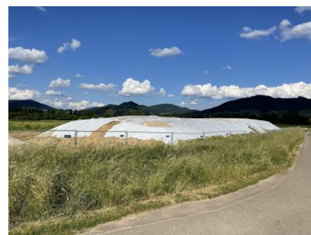
Abb. 8: Unter der weißen Plane liegt PFAS-belasteter Boden, der rund um das Bühler Wasserwerk abgebaggert wurde.
