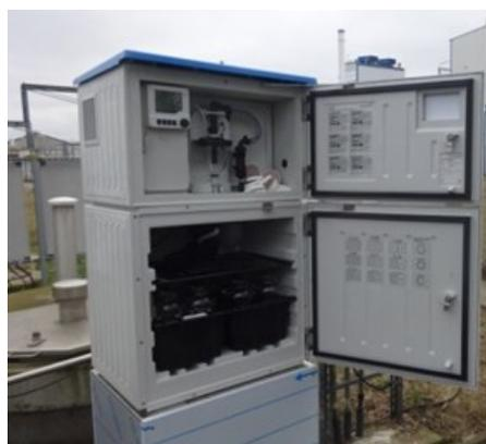
Abb. 2: Probenahme- und Analysestation für die Überwachung der Schmutzabwassereinleitungen in das Abwassernetz des Chemieparks
