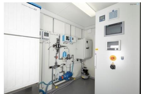
Abb. 1: Begehbare Messcontainer für die Überwachung der Gewässereinleitung
