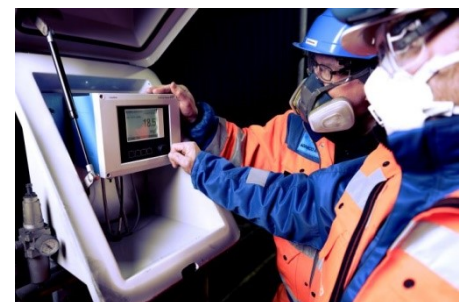
Der Liquiline Multiparameter-Messumformer überträgt die pH-Messwerte an die Steuerung der Chemikaliendosierung.
