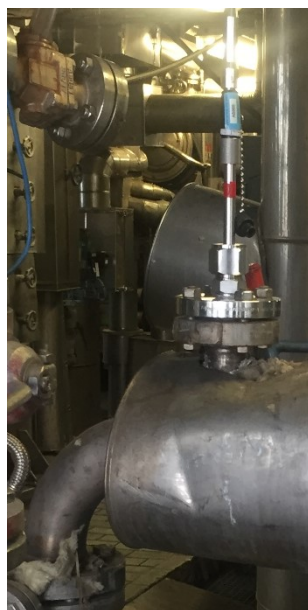
Abb. 6: Installation der Sonden in die Produktleitungen von Blase und Kopf einer Batch-Destillationskolonne.
