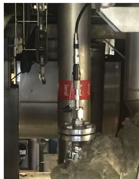
Abb. 6: Installation der Sonden in die Produktleitungen von Blase und Kopf einer Batch-Destillationskolonne.
